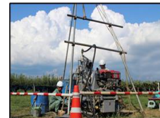
ボーリング調査
