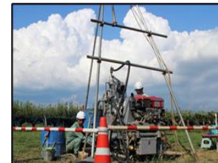
ボーリング調査
