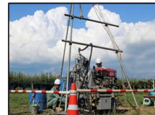
ボーリング調査
