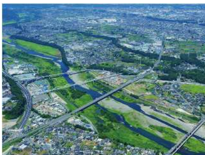
< 圏央道ICと工業団地 >
