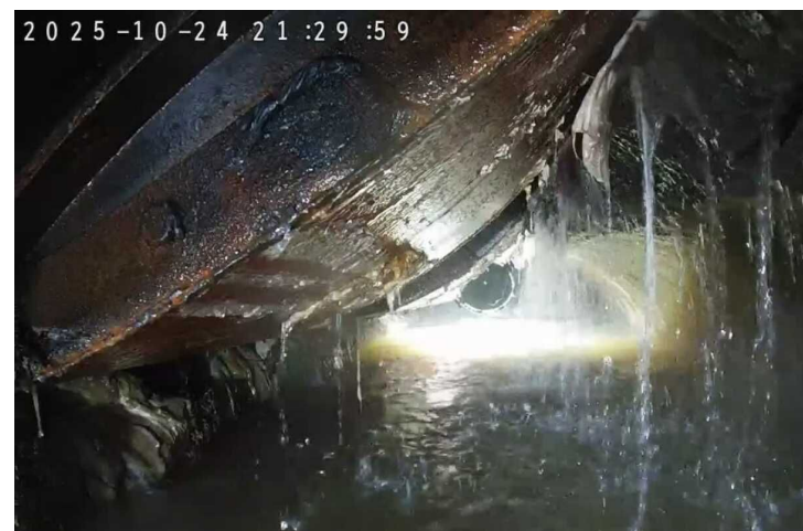
接合部間詰め実施前(10/24)
