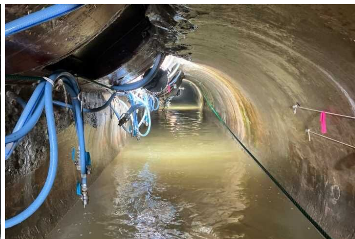
裏込め未充填部への注入後(12/5)
