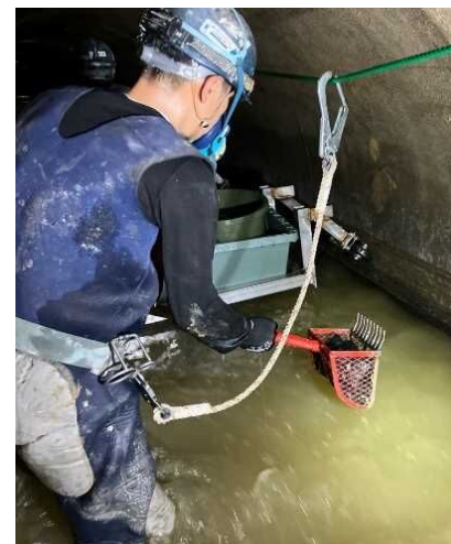
作業状況 (ジョレンにより管底まで清掃を実施)
