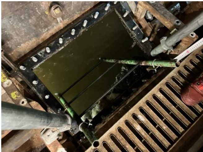
東電シールドに設けた開口 (約60cm×約45cm)
