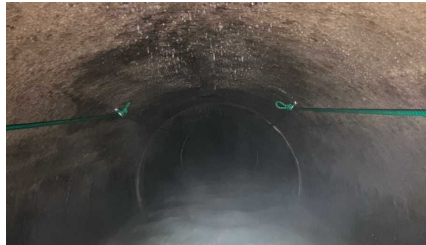
流域下水管内安全対策 (親綱を設置し、作業員の流下防止)
