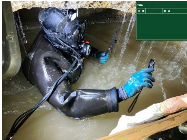
入孔前の潜水土による調査 (硫化水素が発生しないこと等を確認)
