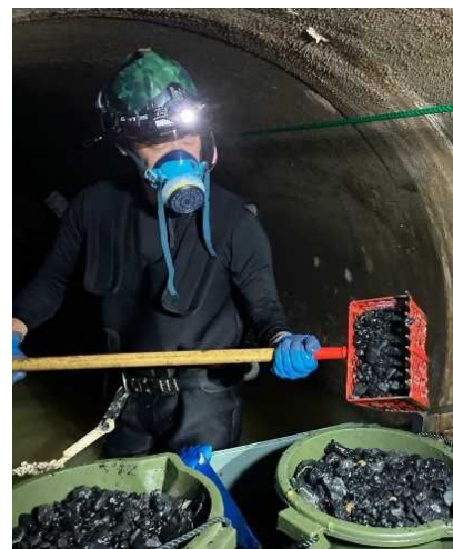
作業状況 (ジョレンにより管底まで清掃を実施)
