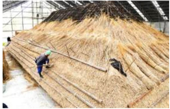
図 4-3 旧青柳庫裏の屋根葺き替え修理
