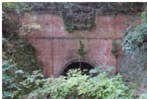
図 3-8 横浜水道 川尻隧道下口
