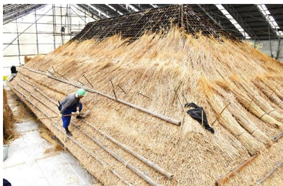
図 5-3 旧青柳庫裏の屋根葺き替え修理
