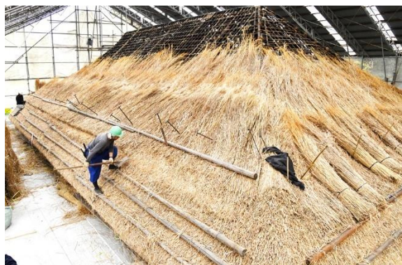
図 5-3 旧青柳庫裏の屋根葺き替え修理
