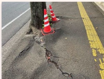
根上がりによる歩道の亀裂
