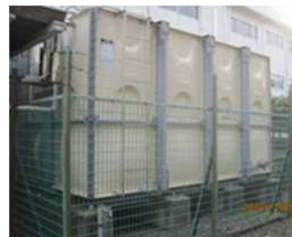
【緊急遮断弁付き受水槽外観】
