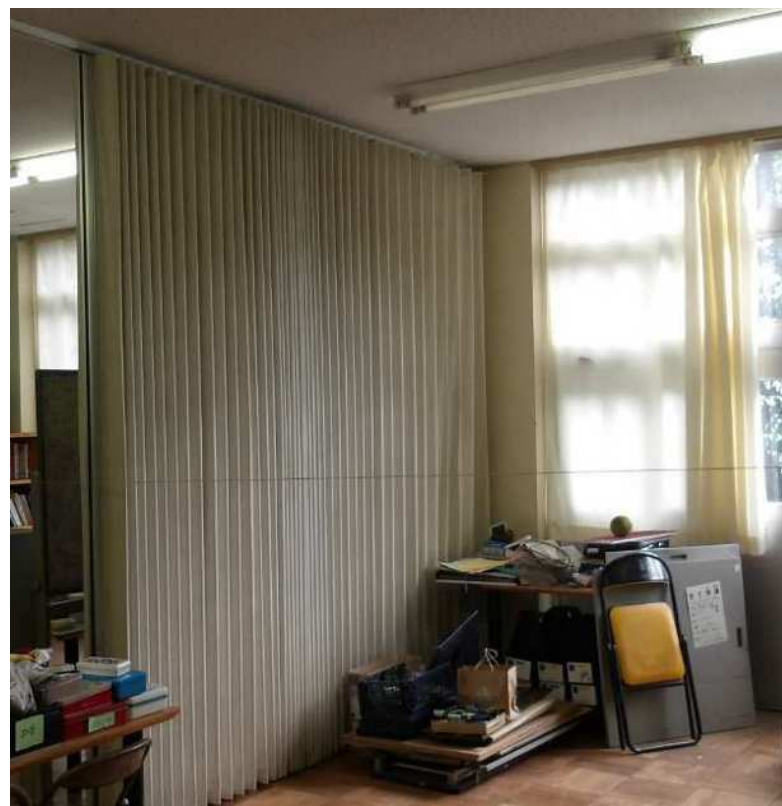
天井吊り間仕切り アコーディオンカーテン【撤去】
