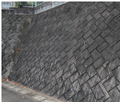
間知ブロック積み擁壁（谷積み）
