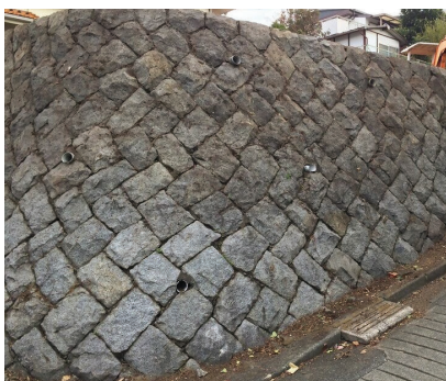
間知石積み擁壁
