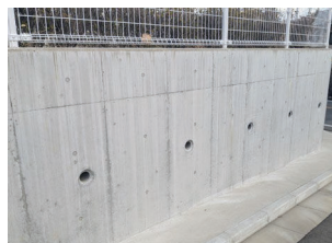
鉄筋コンクリート造擁壁（L型擁壁）
