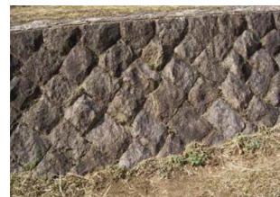
間知石積み擁壁・雑割石積み擁壁
