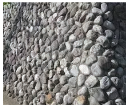
自然石積み擁壁
