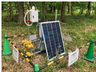
モニタリング機器と太陽光発電システム
