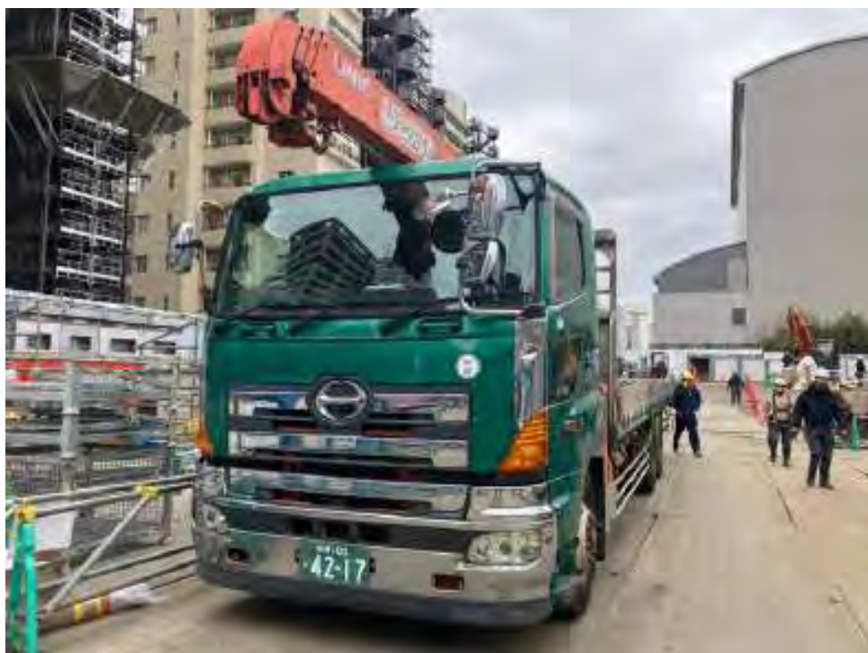
写真 4. 1-1 排出ガス規制適合車の使用（車両全体）
