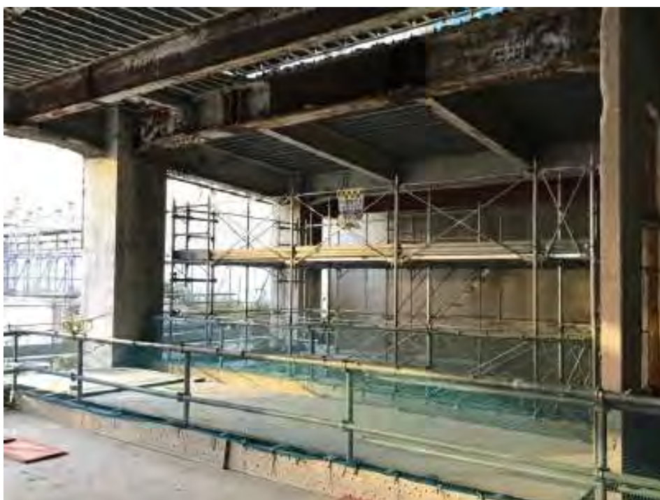
写真 4. 5-2 既存建築物の利用
