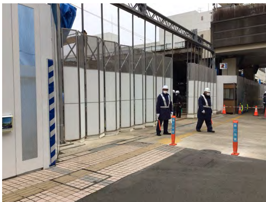
写真 4.6-1 誘導員の配置
